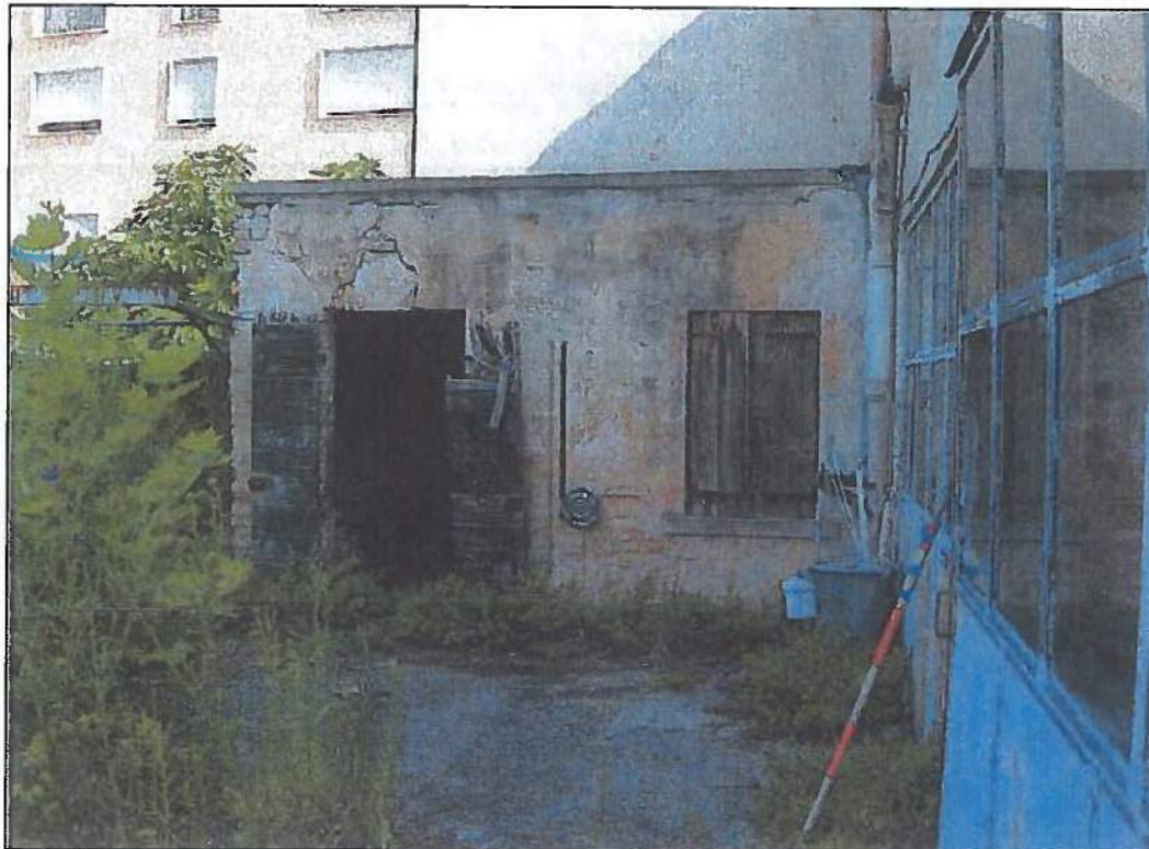
Figura 12: Foto 3 dello stato di fatto.
