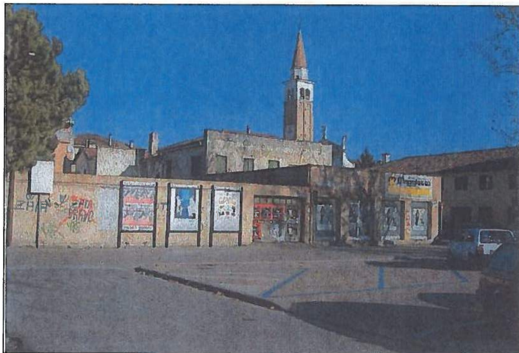
Figura 10: Foto 1 dello stato di fatto.
