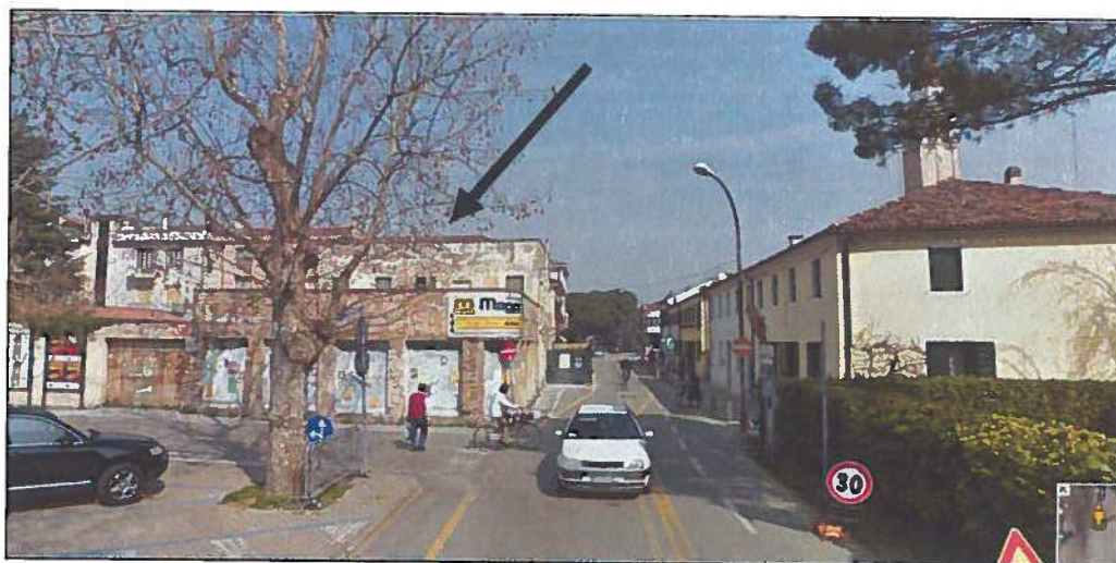
Figura 2. Area di intervento vista da sud – via XXIV Maggio
