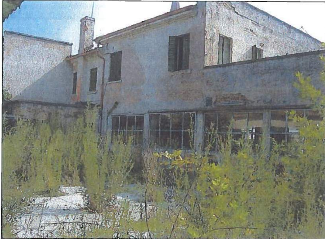
Figura 11: Foto2 dello stato di fatto.
